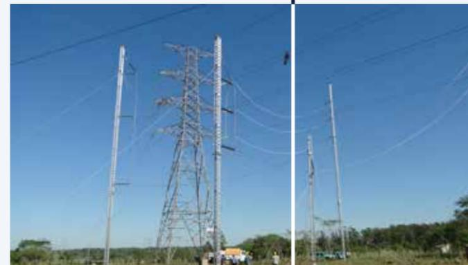
Nos tours d'urgence en aluminium se distinguent par leur facilité de transport et d'installation. Elles permettent à nos clients de rétablir le courant sur les lignes électriques en maintenance ou endommagées, en quelques heures ou en quelques jours, plutôt qu'en plusieurs mois.
